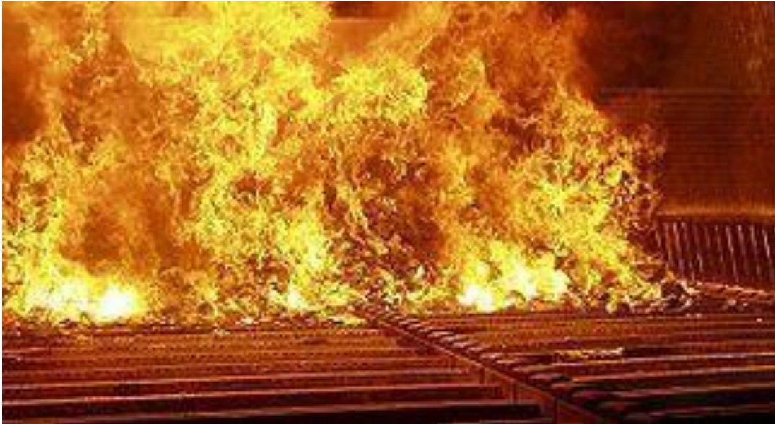
Forno Incinerador de uma Usina de Incineração
