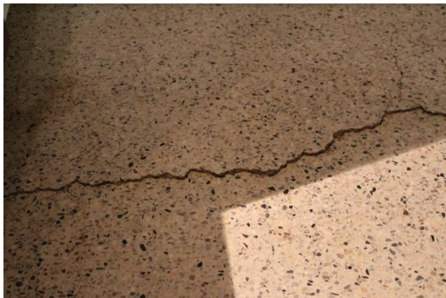
5.11.4.5. Trinca entre passeio e a edificação.
