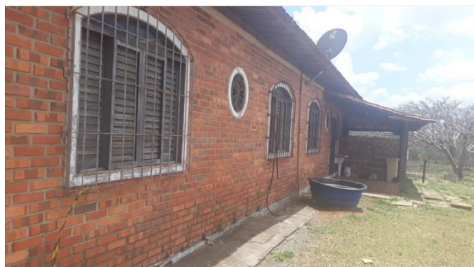
Imagem - 39 – Sistemas elétricos e hidráulicos
