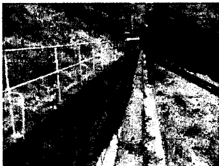
Figura 03 – Canal de adução (conduto livre).
