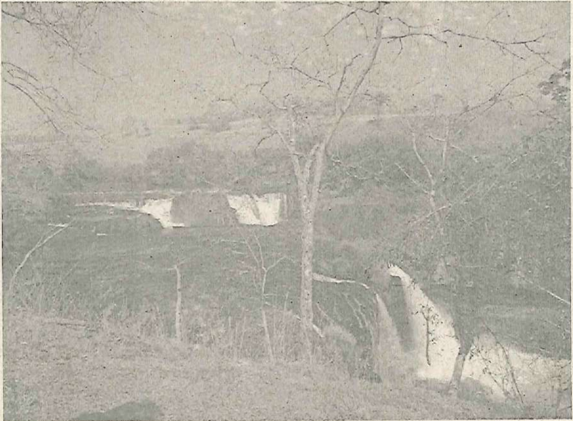
Figura 3. Vistas das quedas no Trecho de vazão reduzida
