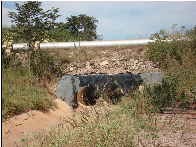
Figura 4- Condutos forçados e tubulação de água que passa sobre ele:
