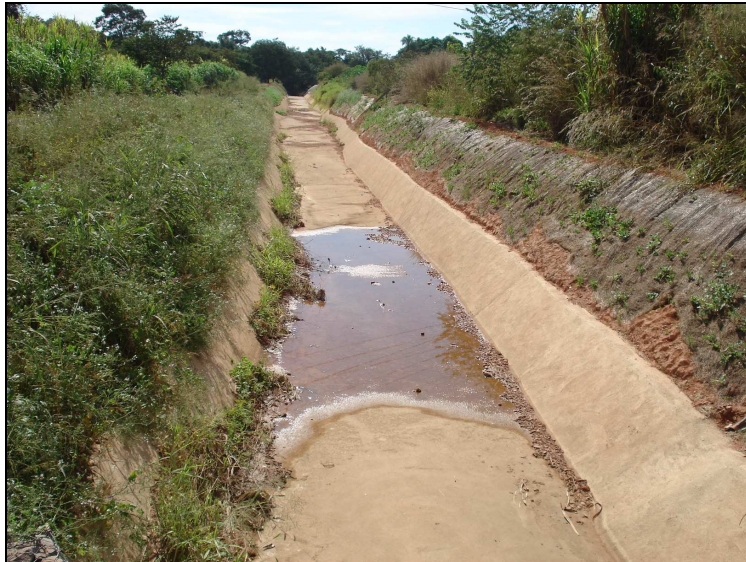
Figura 1 e 2- Parte do trecho impermeabilizado:
