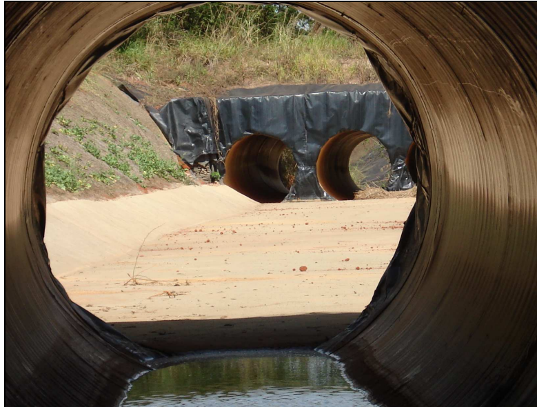
Figura 5- Vista do trecho de único conduto fechado com imagem para o trecho de dois condutos:
