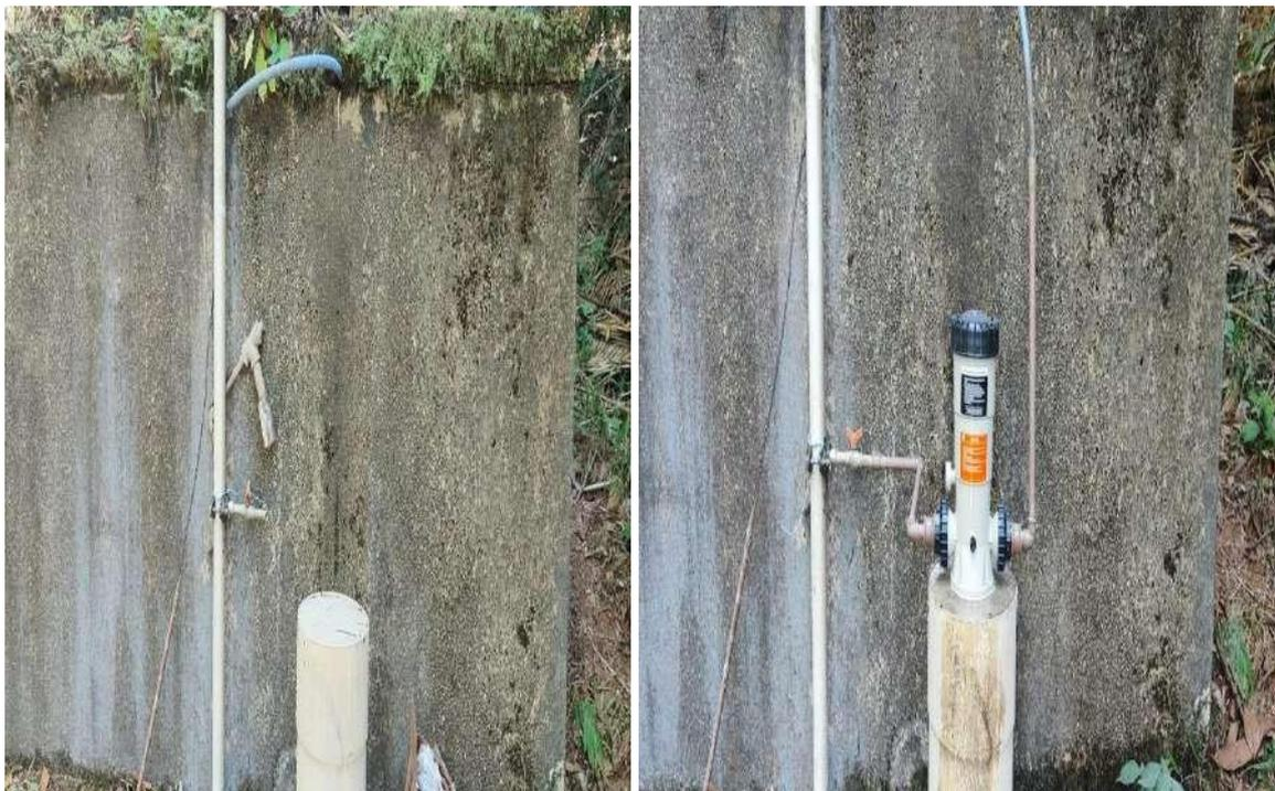
Figura 13. Instalação de clorado nas caixas d'água da península.
