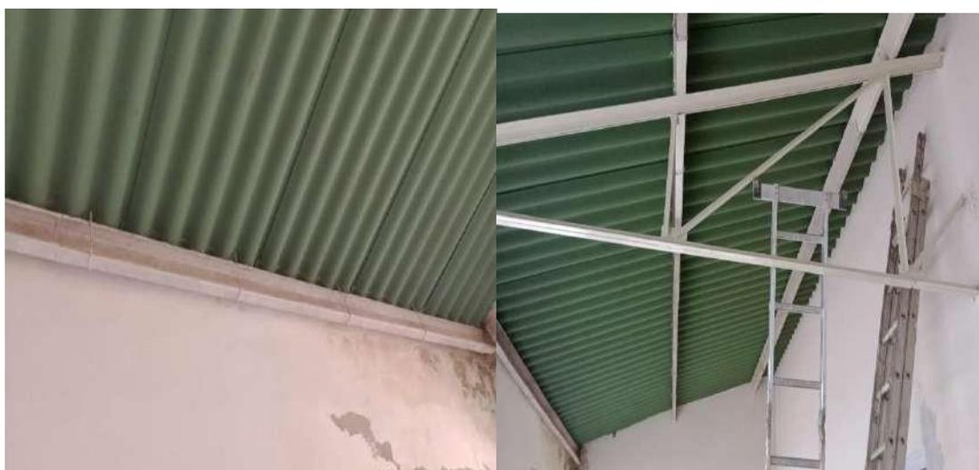
Figura 2. Manutenção no telhado do corredor de acesso à Sala Florestal com retirada de vazamentos. Pintura do telhado com três demãos de tinta de esmalte sintético.
