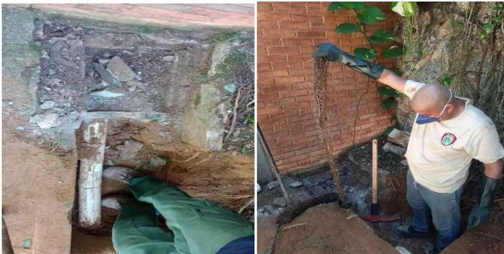
Figura 5. Desobstrução de toda rede de esgoto do banheiro próximo a Capela. Local se encontrava tomado de raízes de vegetações em suas proximidades.
