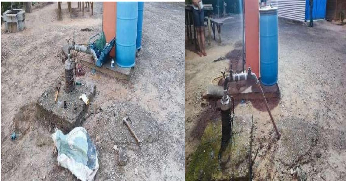
Figura 23. Manutenção em bomba do posto de abastecimento da caixa d'água da Ponte Perdida.
