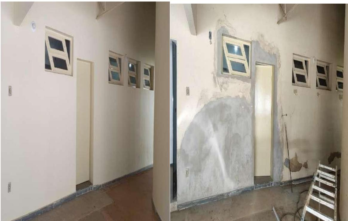
Figura 4. Recuperação do revestimento com argamassa AC2 e finalização com três demão de tinta.
