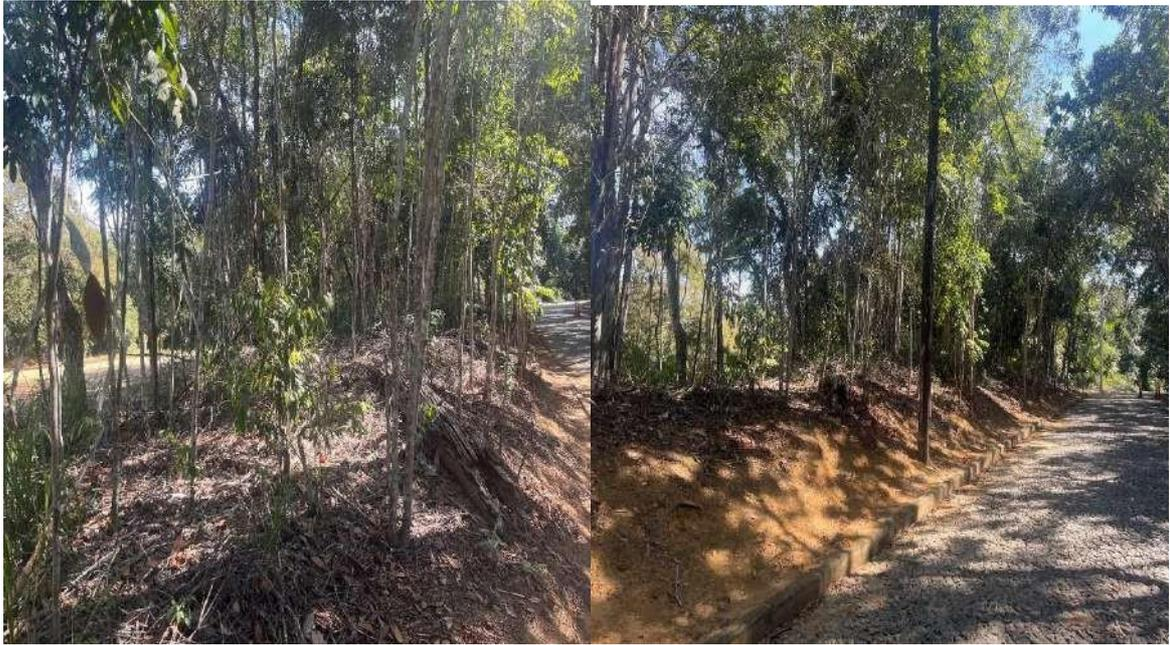
Figura 17. Retirada de vegetação das margens da via de acesso da área de camping.
