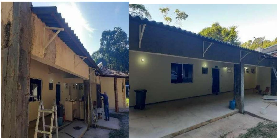
Figura 1. Fachada do lado direito da sala, reparos nos rebocos estourados com cimento, cal, areia e finalização com três demãos de tinta.
