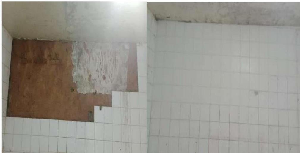
Figura 9. Fixação de revestimento na câmara fria com argamassa AC2 com manutenção em todos os rejunte.
