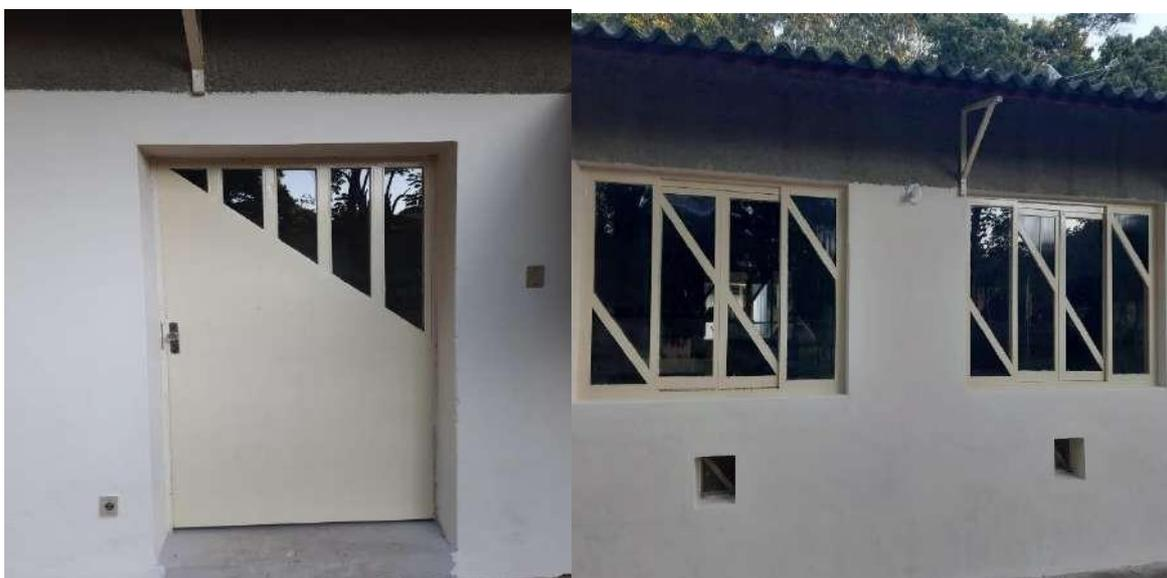
Figura 10. Finalizados reparos em todo revestimento das paredes com argamassa AC2 e pinturas com três demão de tinta em paredes, janelas e portas nas áreas internas e externas da estrutura da sala de beneficiamento de sementes.
