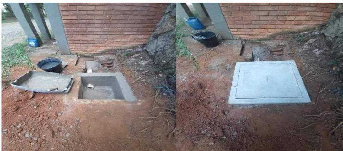
Figura 6. Manutenção em caixa de passagem próxima a Capela. Confecção de nova caixa com concreto armado com tampa de vedação.
