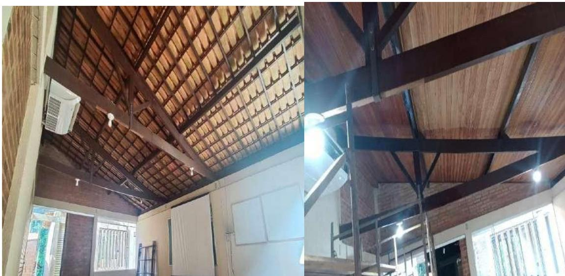
Figura 19. Fixação de forro de madeira de angelim pedra com aplicação de três demãos de verniz sala de reunião principal do centro de treinamento.
