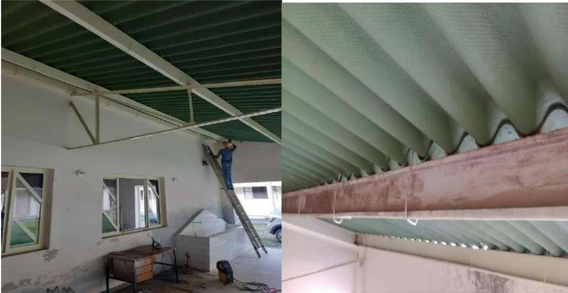
Figura 11. Pintura finalizada com três de mão de tinta (esmalte sintético) na estrutura metálica do telhado da sala de beneficiamento de sementes.
