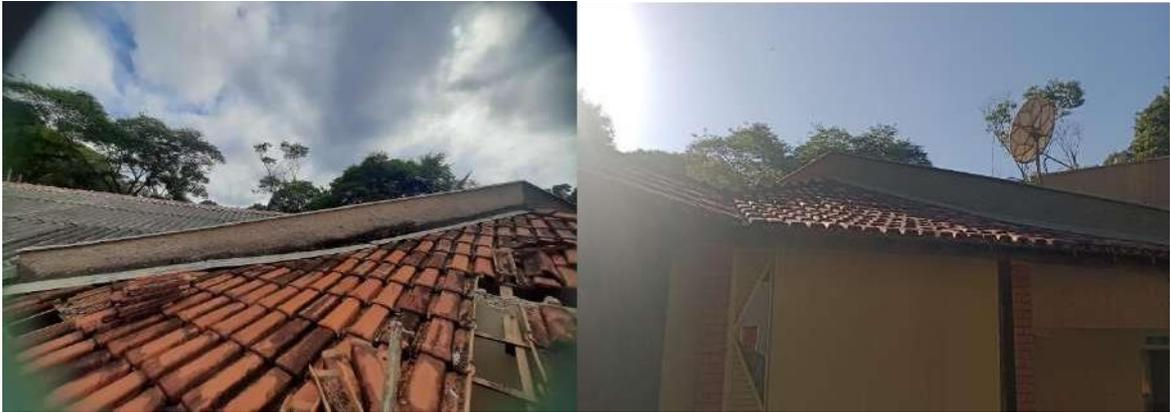
Figura 15. Manutenção na estrutura do telhado com substituição de telhas quebradas, que ocasionavam vazamentos em período chuvoso (Sala Redonda próxima herbário).
