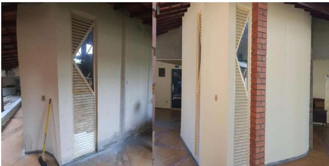
Figura 14. Revitalização em toda área externa da Sala redonda (próxima ao Herbário), reparos com argamassa AC2 nos revestimentos onde se fez necessário. Posteriormente, aplicamos três demãos de tinta.
