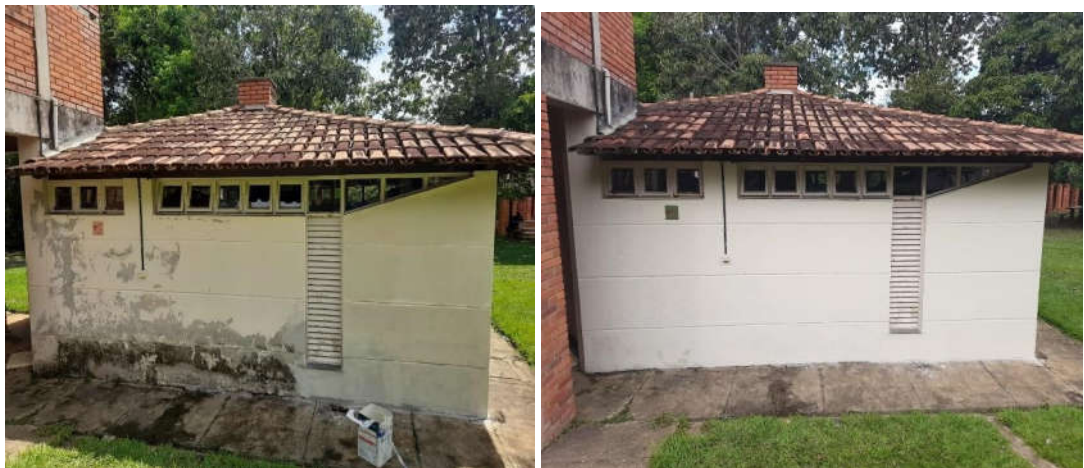
Figura 09. Estruturas área de camping. Renovação das pinturas das paredes. Essa foi uma maneira relativamente fácil e econômica de renovar a aparência dos ambientes.
