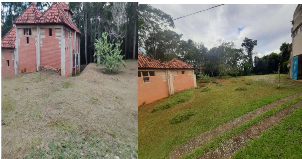
Figura 23. Centro de Visitantes. Poda de todo gramado ao redor das estruturas.
