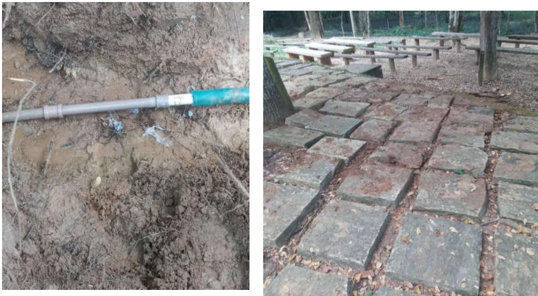
Figura 33. Retirada de vazamento na rede mestre de abastecimento de água potável do Centro de Manutenção.
