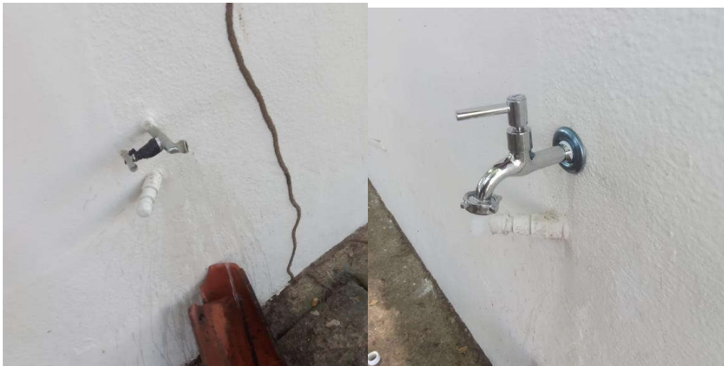
Figura 35. Substituição de torneiras de jardim.
