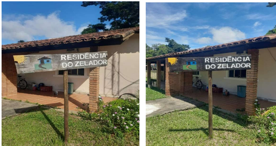
Figura 11. Centro de treinamento. Revitalização da pintura das placas.
