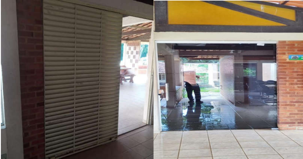
Figuras 32. Substituição de todas as portas de metal por portas de vidros na sala principal de reunião no Centro de Treinamento.
