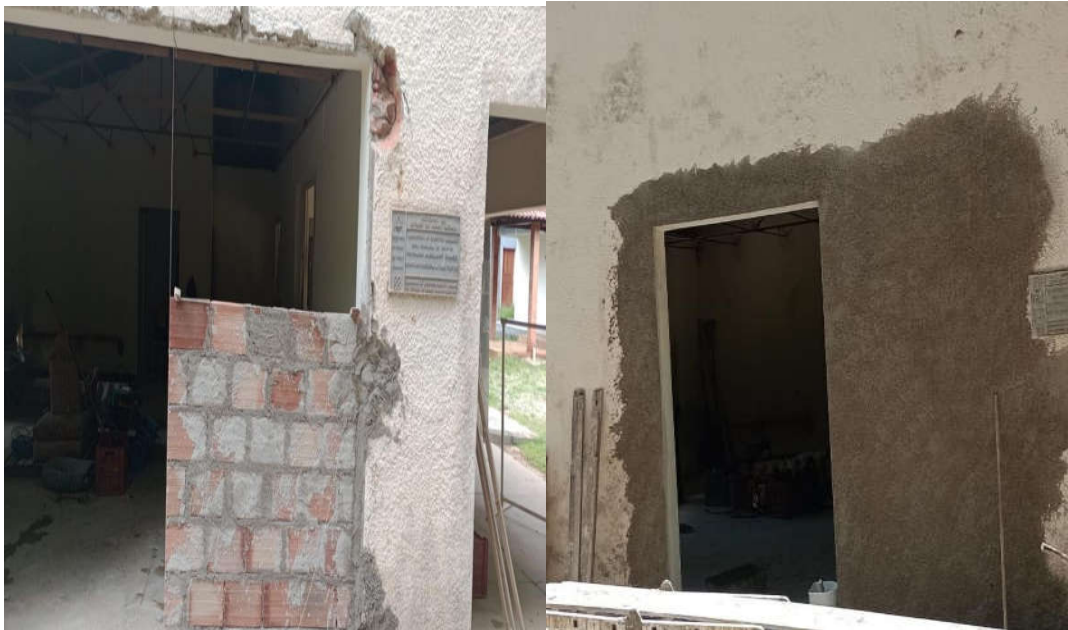
Figura 13. Sala de Reunião Florestal. Manutenções em todas as portas de acesso para receber novas portas de vidro.
