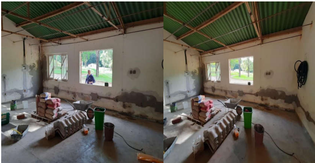
Figura 18. Sala de Reunião Florestal. Retirada de todas as janelas com restauração de suas espaldas para receber novas janelas de vidro com esquadrias de alumínio.
