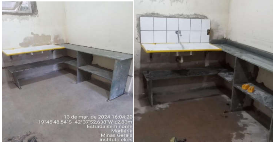
Figura 25. Reparo de manutenção sala de apoio próximo ao herbário.
