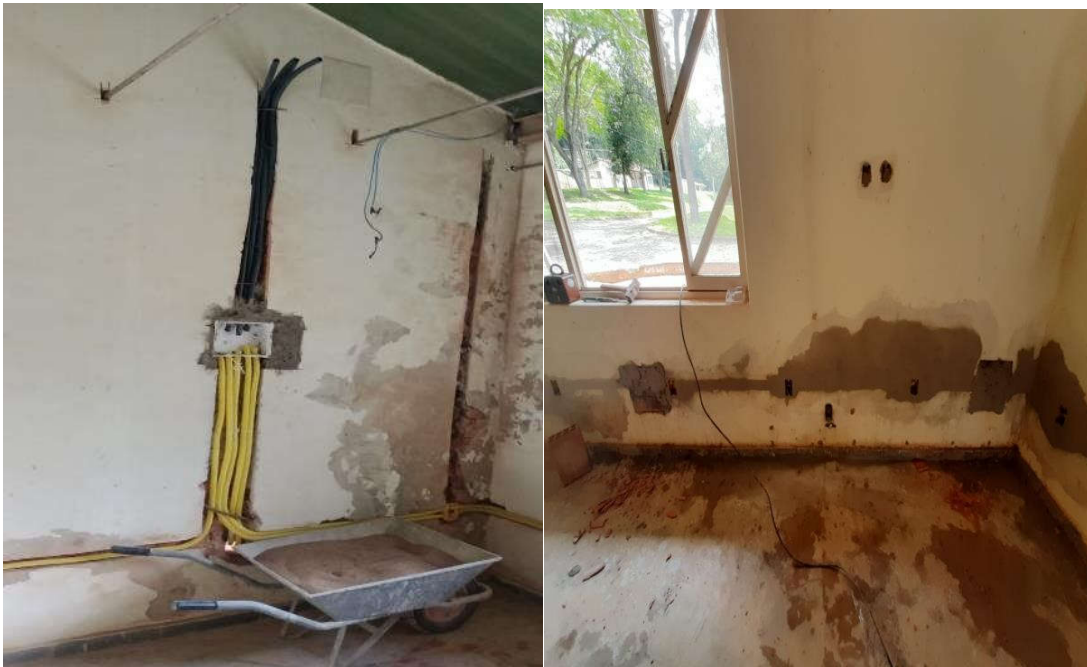
Figura 17. Sala de Reunião Florestal. Manutenção com instalação de eletrodutos e fixação de novo quadro elétrico com extensão de mais saídas de caixas para tomadas.
