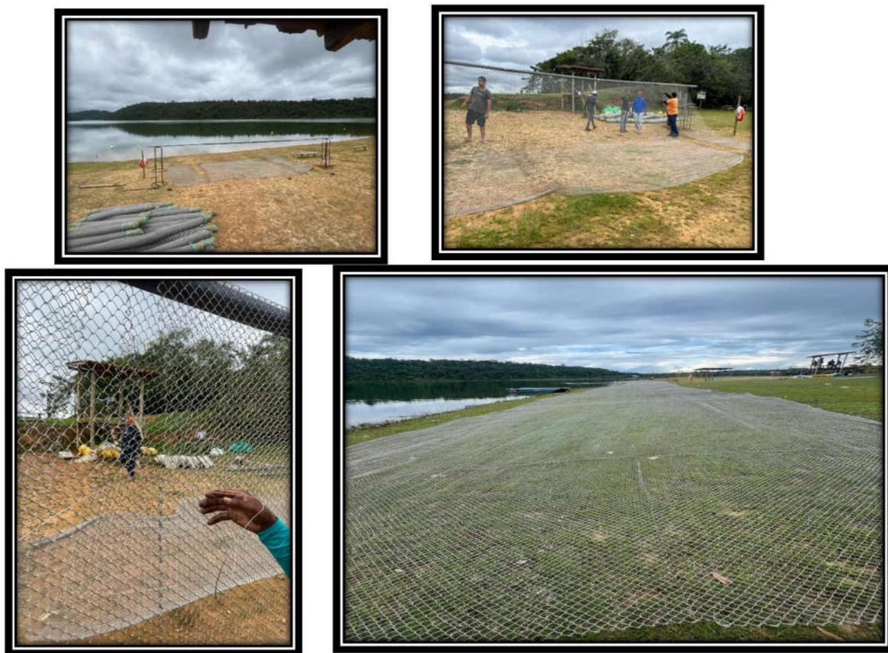
Figura 4 – Costura das telas / Paredão de 100M
