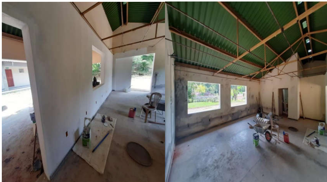
Figura 19. Sala de Reunião Florestal. Início de toda preparação das paredes para receber as primeiras de mão de tinta.
