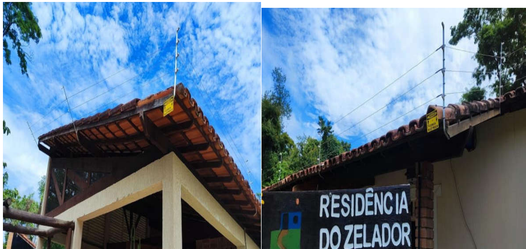
Figuras 31. Fixação de cerca elétricas no beiral das estruturas com manutenções nas existentes em todas as estruturas centro de treinamento.
