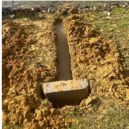
Figura 8 – Abertura das Canaletas
