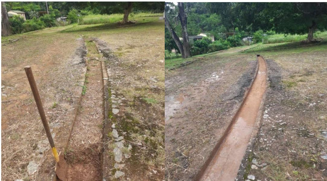
Figura 14. Estruturas Sementeiras. Limpezas em todas as sarjetas de drenagem de água.
