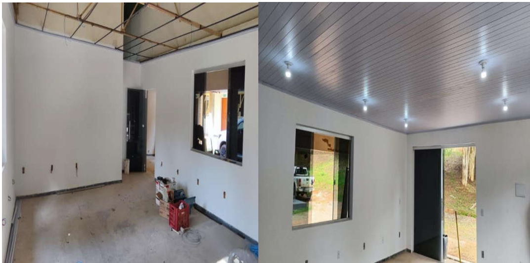
Figura 27. Fixação forro em PVC no interior sala de reunião florestal.
