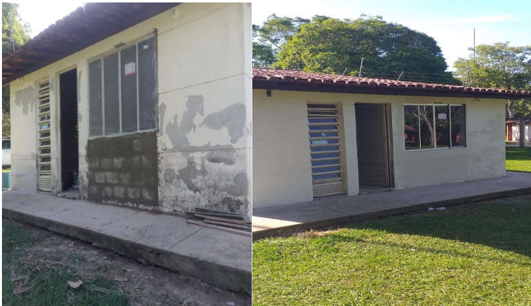
Figura 08. Área de camping. Manutenção do Posto de Apoio dos Agentes de Parque.
