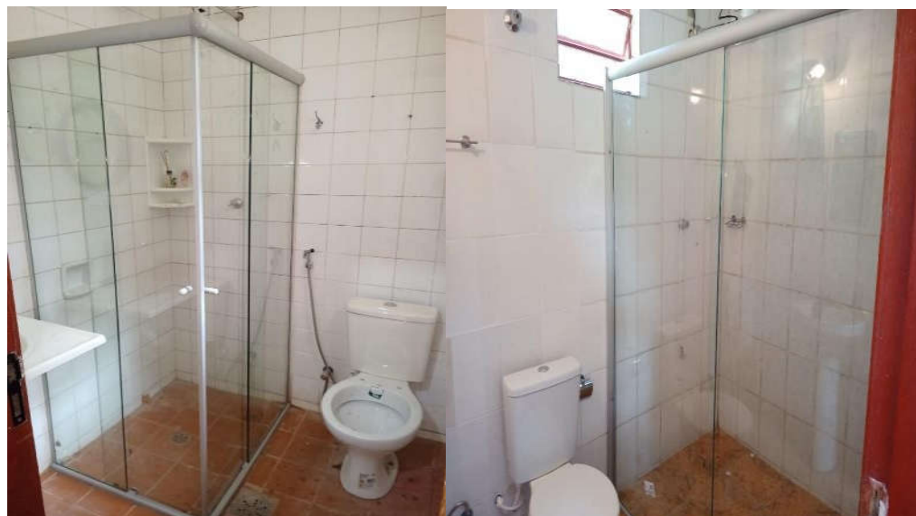
Figura 15. Estruturas sanitárias. Substituição de todos os acentos sanitários em toda península do PERD.
