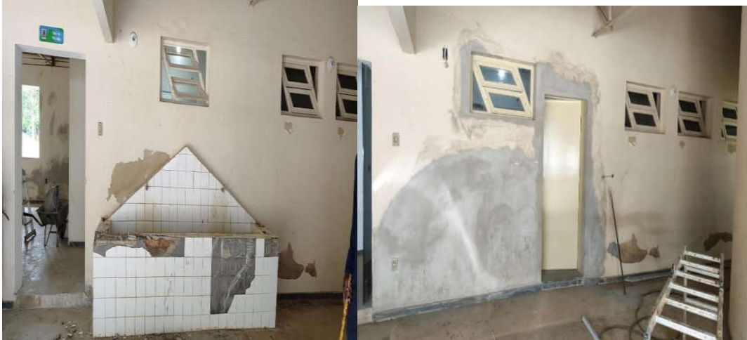
Figura 34. Retirada de tanque de alvenaria inutilizado do corredor de acesso à porta da sala de reunião florestal.
