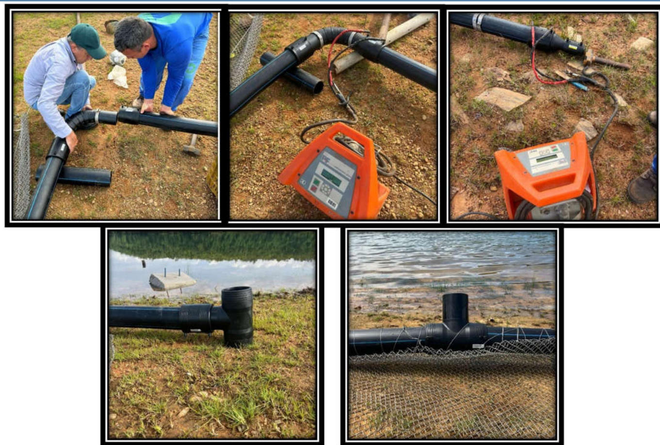
Figura 6 – Soldas por eletrofusão
