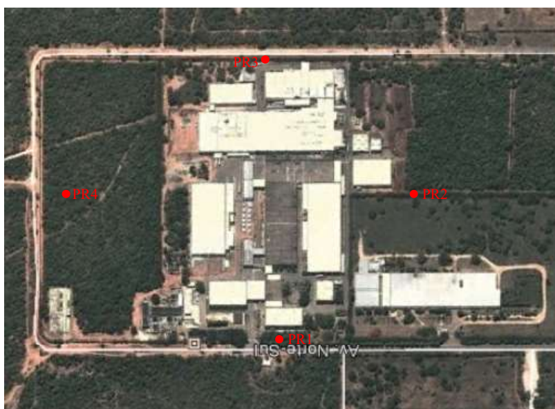
Figura 01 – Ponto de monitoramento dos níveis de ruído
