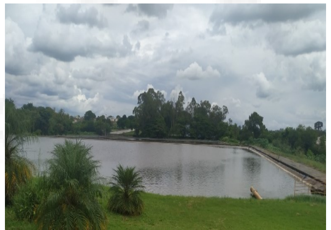
Foto 02. Estação de Tratamento de Esgoto
