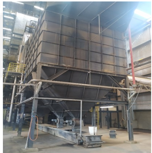
Foto 04. Área da Caldeira
