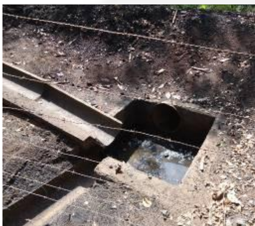
Foto 07. Canaletas para drenagem pluvial.
