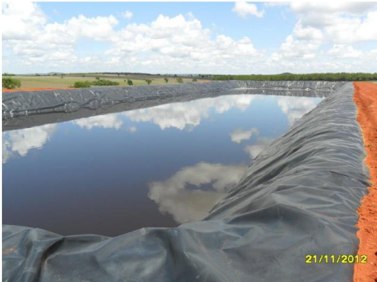
Foto 07. Print do relatório fotográfico acostado no processo - vista da lagoa situada a jusante dos biodigestores, impermeabilizada com PEAD
